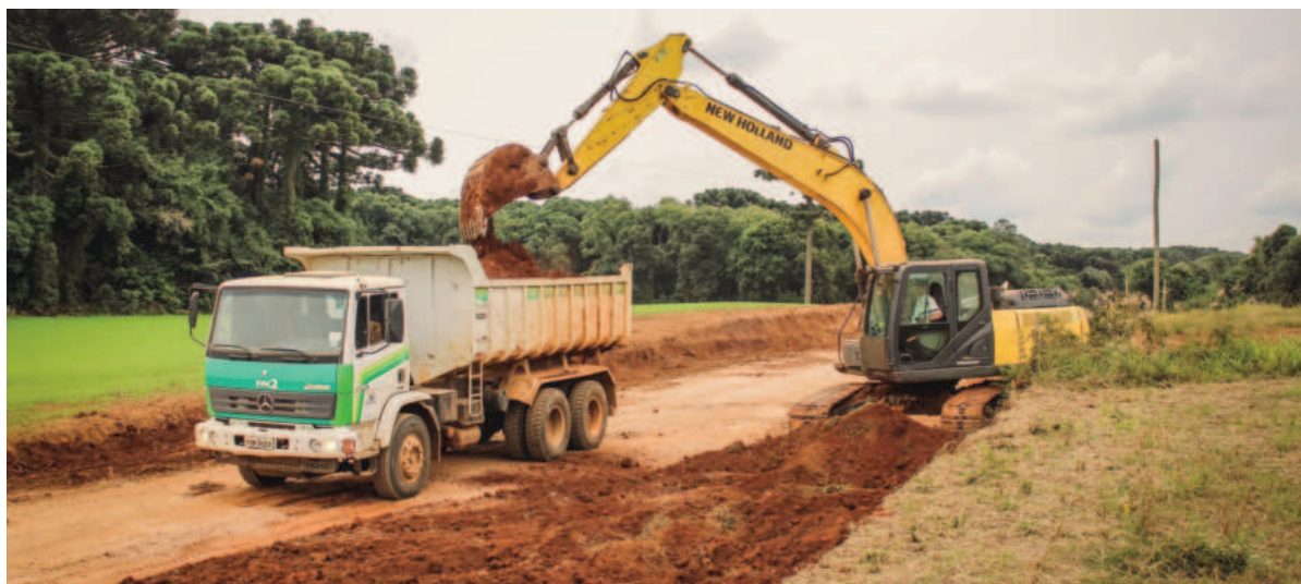
Estrada está sendo alargada para 12 metros
